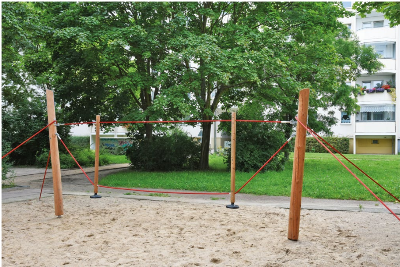
Das Foto zeigt abweichende Abspannseile
