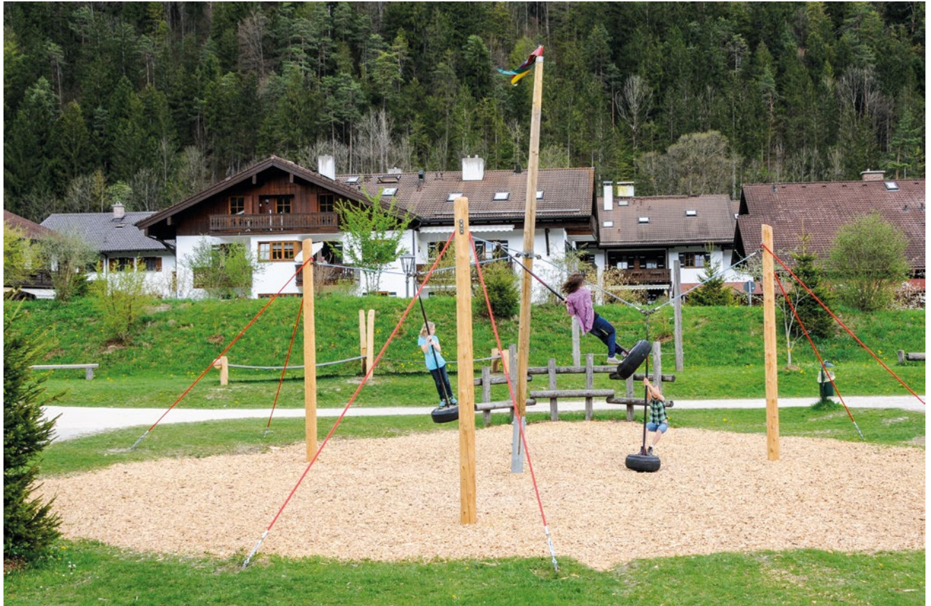
Das Foto zeigt abweichende Abspannseile.
